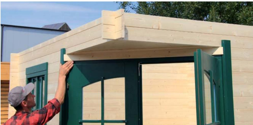
A l'aide d'une équerre orientez le coin au-dessus de la zone d'entrée. Pour éviter qu'il ne se déplace, vissez une planche (déchet de bois contenu dans l'emballage) sur la surface supérieure diagonalement au-dessus du coin. Cette planche devra être retirée après la mise en place et la fixation du voligeage du plafond dans le coin.
