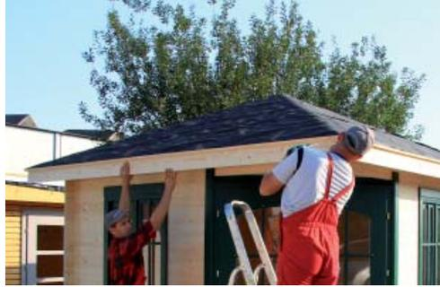
En dernier, placez et fixez un morceau de carton bitumé carré au-dessus du faite.
